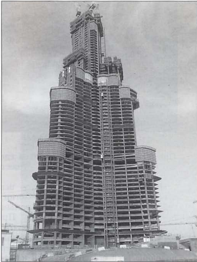
"Дубайская башня" в процессе строительства
